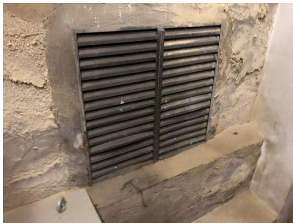
Rejillas antiguo cuarto de ascensores
