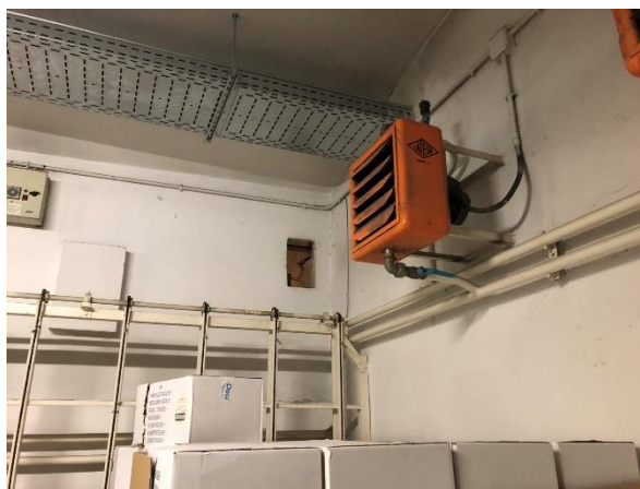
Hueco comunicación lavandería con pasillo
