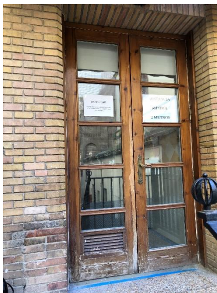
Puerta zona cocinas
