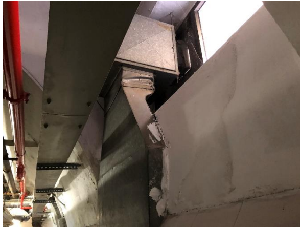
Detalle conducto ventilación aljibe
