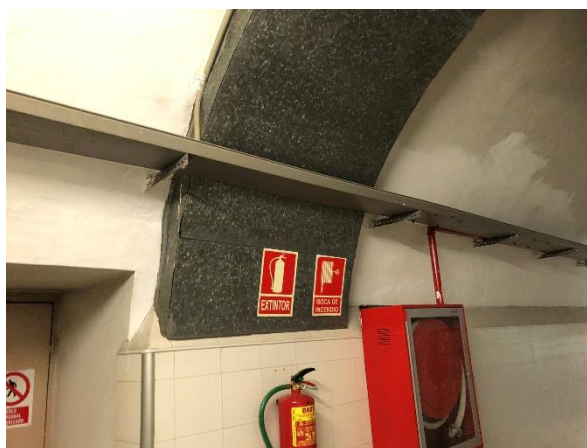
Detalle conducto ventilación aljibe
