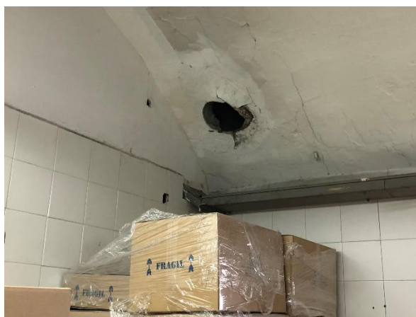
Hueco chimenea fuera de uso
