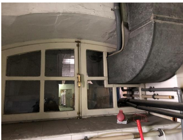
Ventana comunicación garaje-cuarto lavadoras
