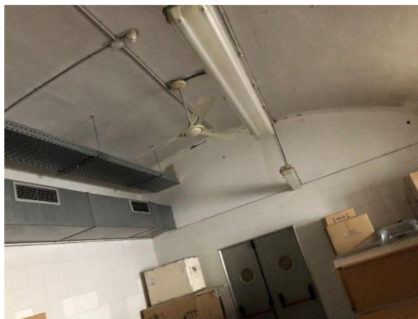
Conducto ventilación entre almacén y antigua lavandería
