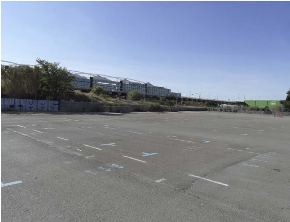
Imagen 6.- Calzada Parquin Sur. Zona Asfalto.
