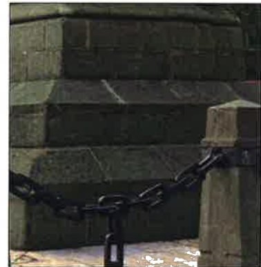
Base del pedestal de piedra de Codos
