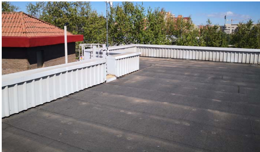
Acceso actual cubierta principal
