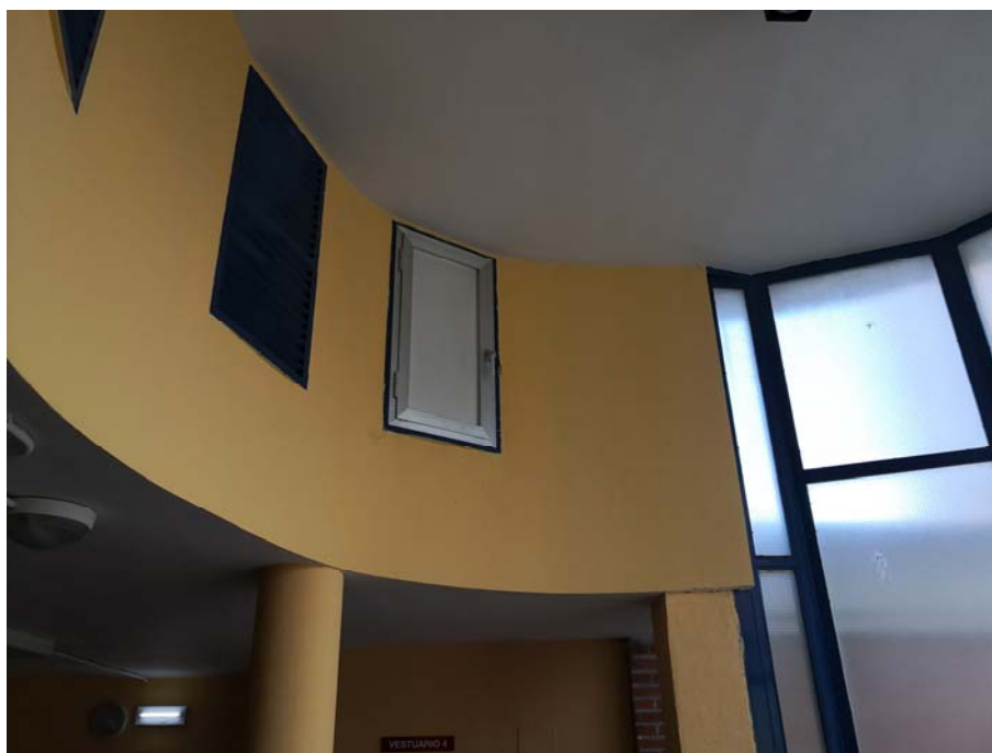
Trampilla de acceso a cubierta
