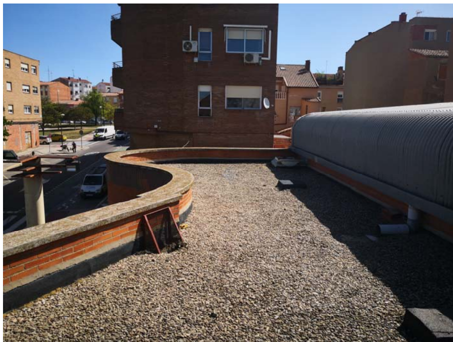
Cubierta plana con claraboya de acceso.
