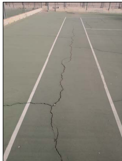
Grietas a reparar
