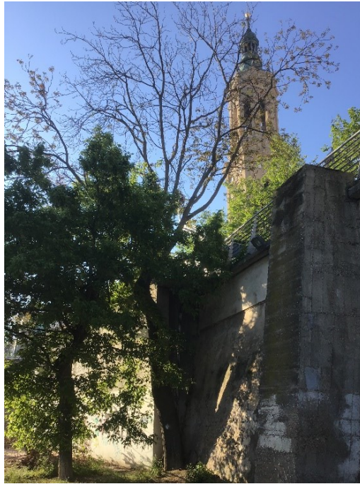
14. Tala ailanto de grandes dimensiones. Vertido a contenedor y gestión de residuos
