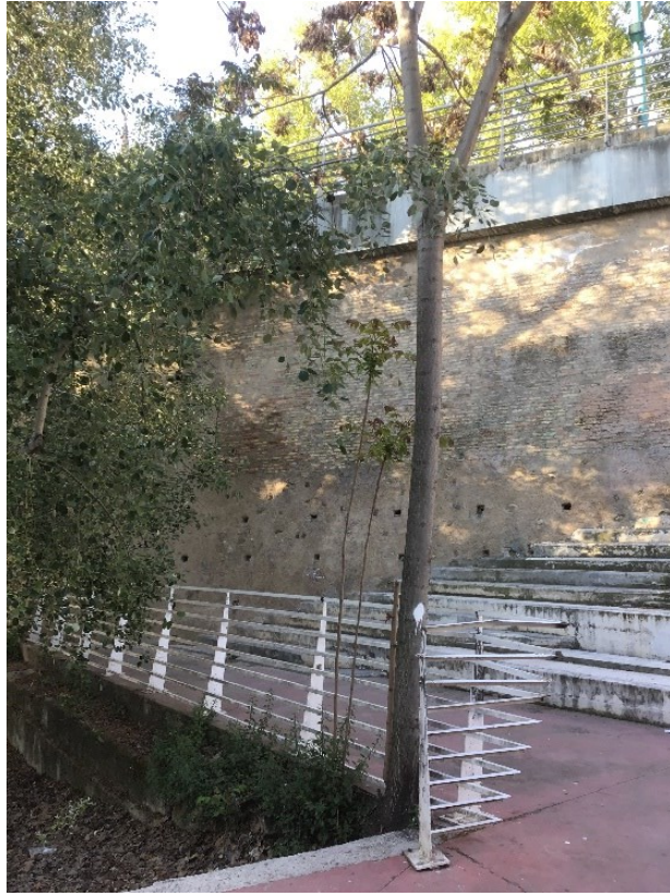
3. Tala ailanto. Vertido a contenedor y gestión de residuos
