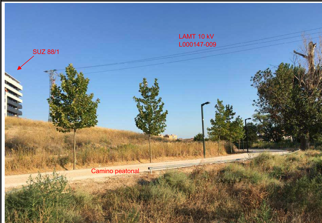
FOTO 9. Línea aérea de media tensión (10 kV) a desmontar
