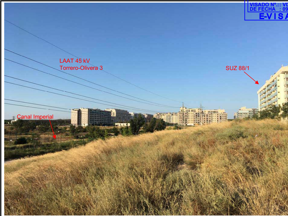
FOTO 3. Línea aérea de alta tensión (45 kV) denominada "Torrero-Olivera 3"
