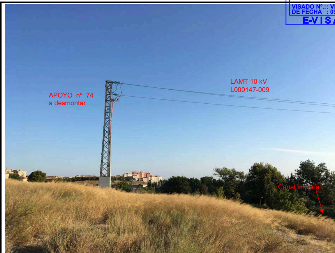
FOTO 8. Línea aérea de media tensión (10 kV) denominada L000147-009. Apoyo nº 74 de conversión aéreo-subterráneo a desmontar
