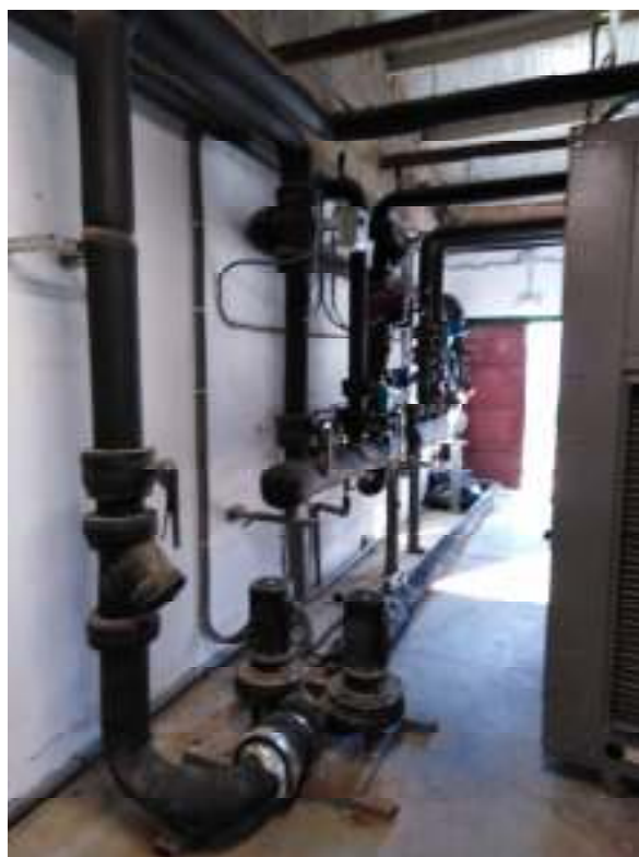
Instalación hidráulica existente
