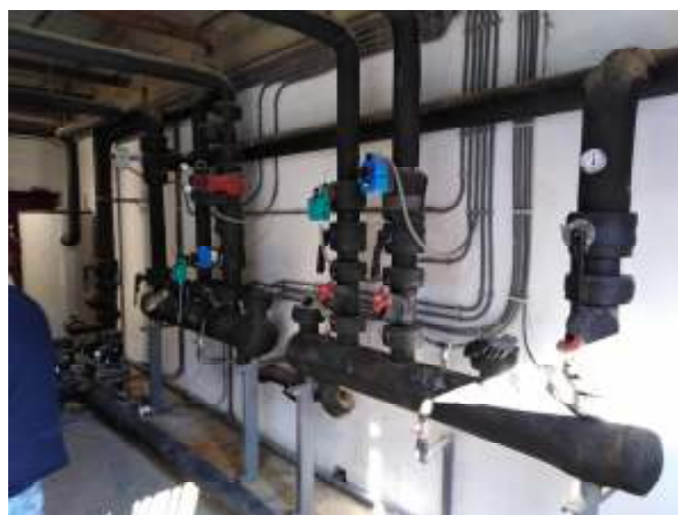
Instalación hidráulica existente
