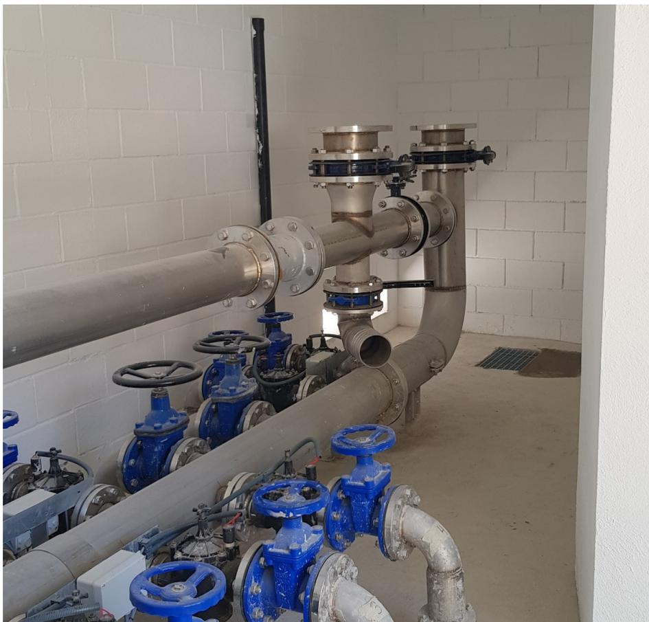
Foto 2. Posición filtro sobre colector
