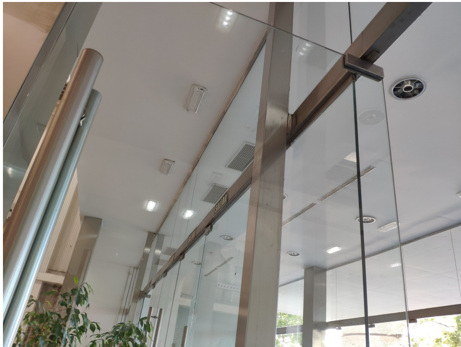
DETALLE EJE PUERTA ABATIBLE. LÍNEA INTERIOR
