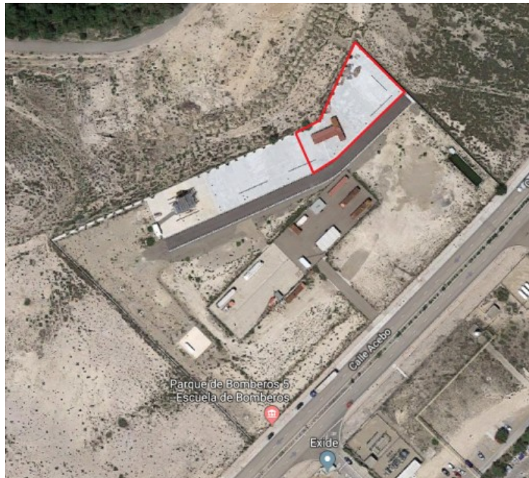
Fotografía 1: Imagen aérea del parque de bomberos nº 5, la zona de ampliación se sitúa dentro del contorno señalado en color rojo.
