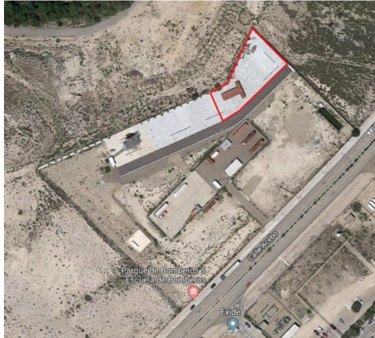
Fotografía 1: Imagen aérea del parque de bomberos N.º 5, la zona de ampliación se sitúa dentro del contorno señalado en color rojo.
