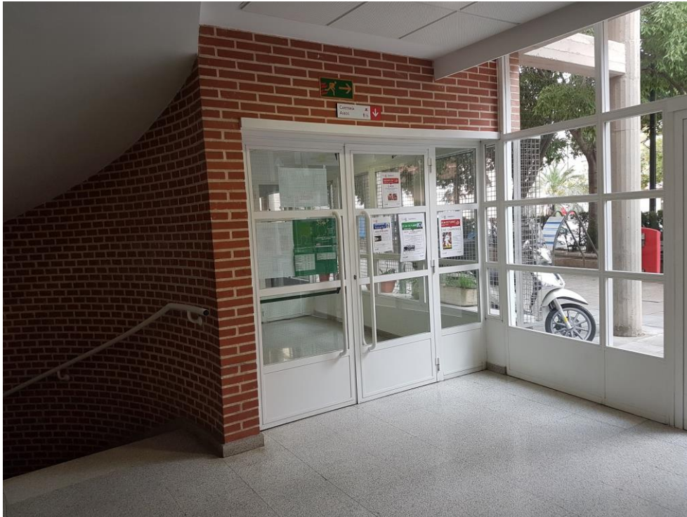
PUERTA DESDE VESTÍBULO PRINCIPAL A PASILLO HACIA CAFETERÍA (VISTA DESDE VESTÍBULO)
