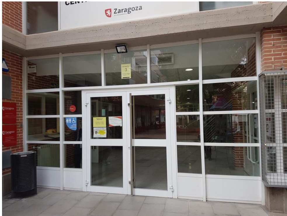
PUERTA EN ACCESO PRINCIPAL (VISTA EXTERIOR)
