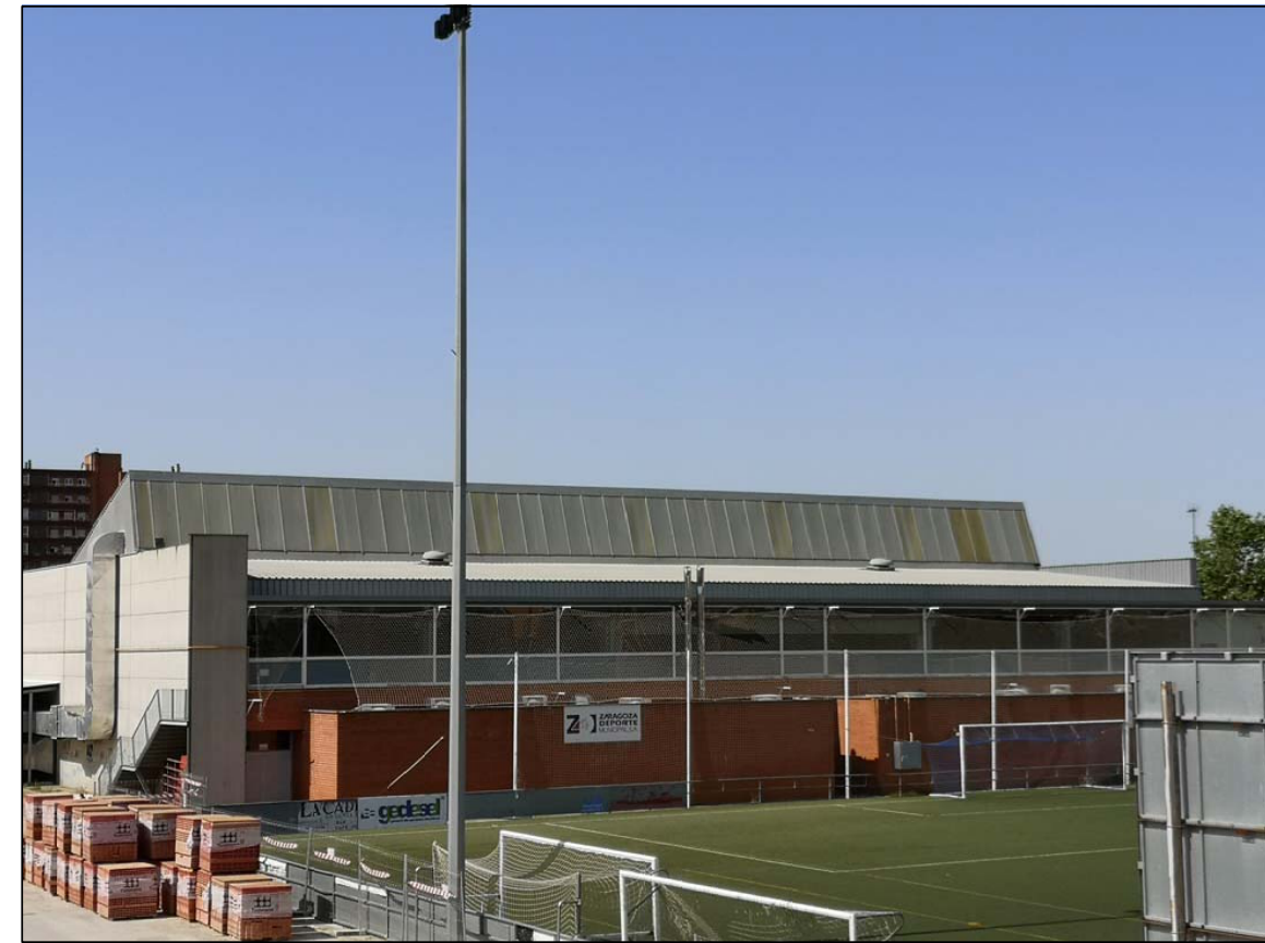
VENTANAL QUE SE SUSTITUYE
