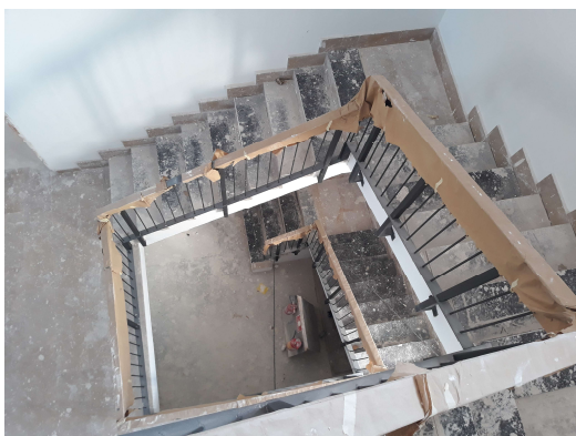
Hueco de la escalera
