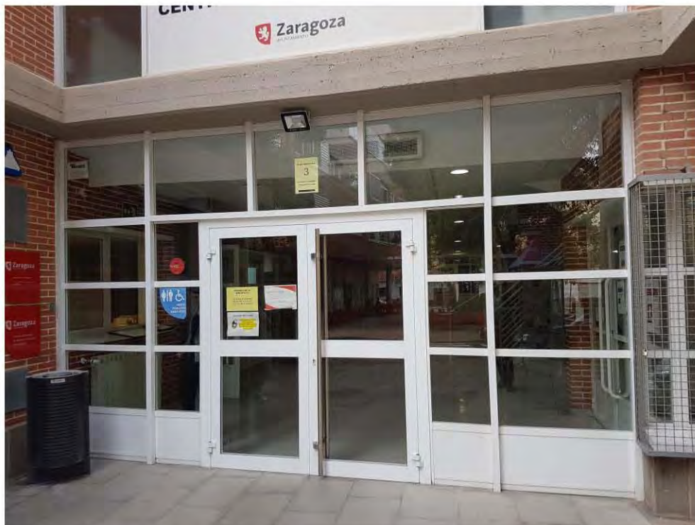
PUERTA EN ACCESO PRINCIPAL (VISTA EXTERIOR)
