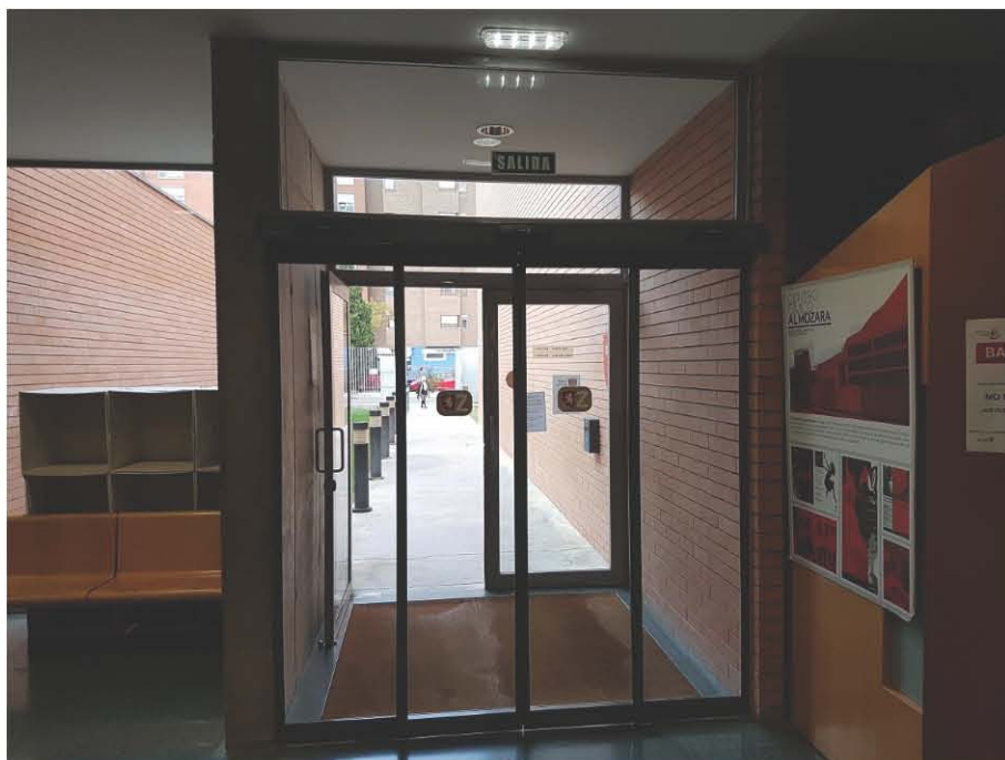
PUERTAS ACTUALES EN ACCESO OESTE (1)
