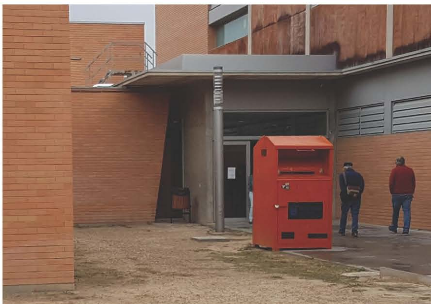
PUERTAS ACTUALES EN ACCESO SUR (VISTA EXTERIOR)
