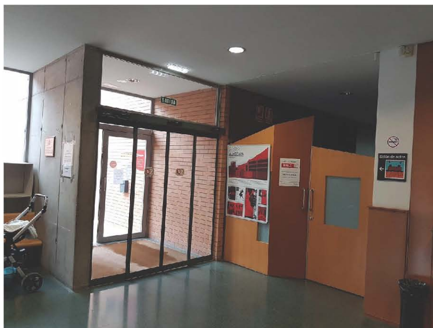
PUERTAS ACTUALES EN ACCESO OESTE (2)
