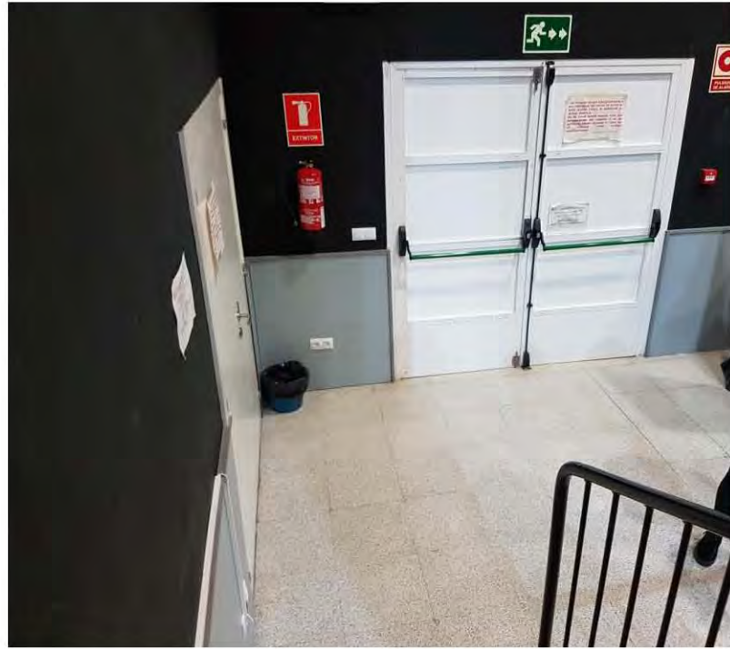
VISTA GENERAL DESDE NIVEL SUPERIOR
