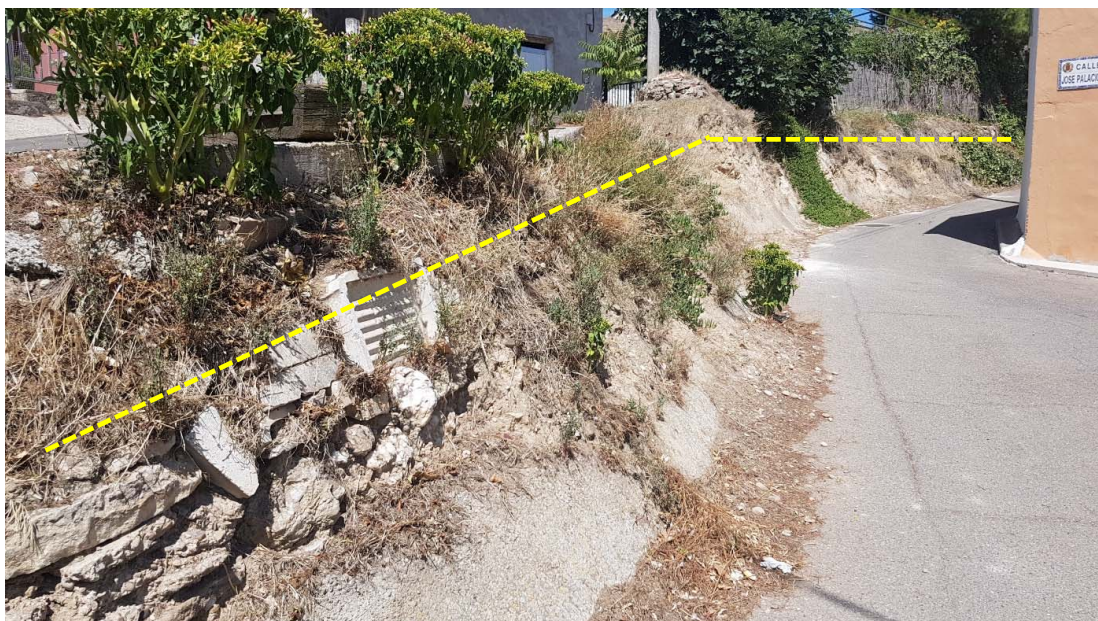
Vista desde el punto inicial (en línea trazos amarillos, silueta de coronación del muro a ejecutar
