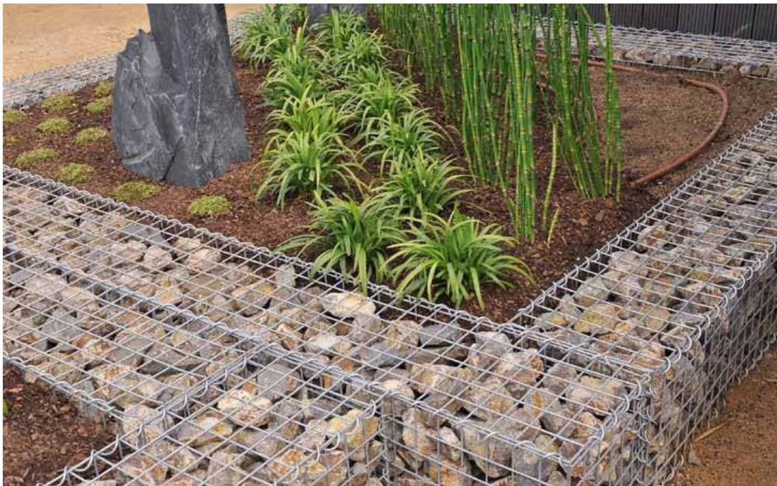
La idea de la jardinera-banco, como apreciamos en las fotografías anteriores, consiste en un murete de gaviones dispuesto como cerramiento de una cavidad que permitirá albergar en su interior vegetación, a modo de jardinera. Asimismo en el muro de gaviones del perímetro se ubicarán bancos de gaviones de manera solidaria.
