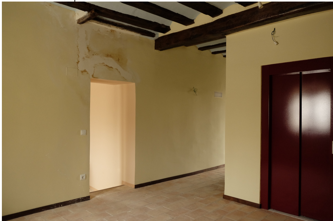
Humedad causada por la chimenea
