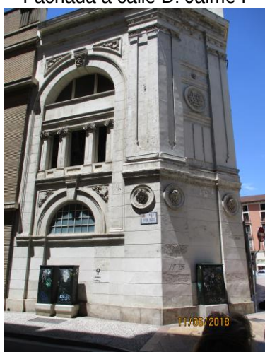
Fachada a calle Eusebio Blasco
