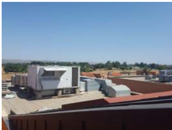
Rooftop existente en cubierta
