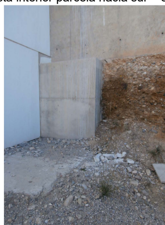
Detalle muro contención nivel inferior.
