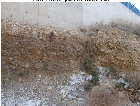
Detalle corte tierras bajo zapata de muro contención
