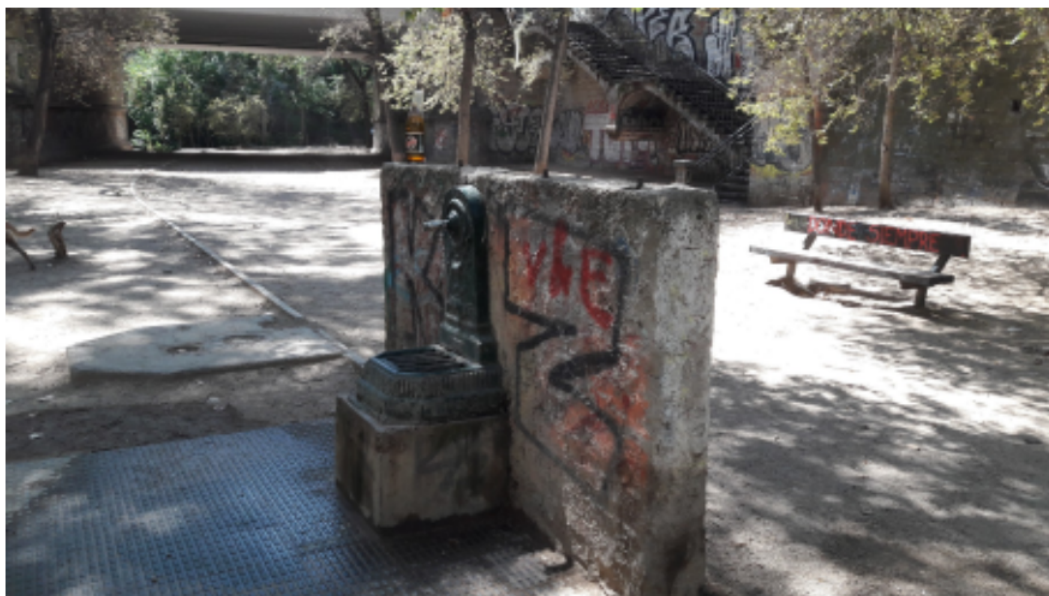
Fotografías nº5.- Vista de fuente y banco a sustituir
