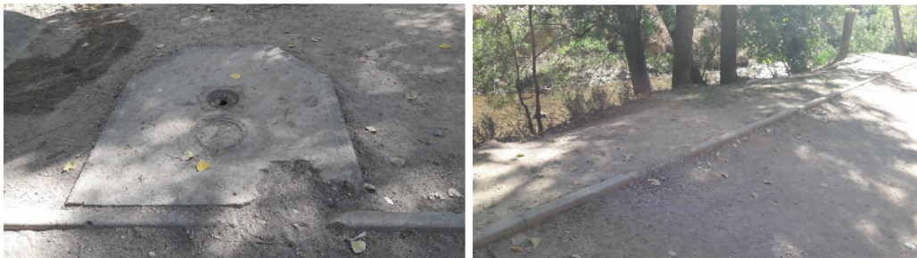
Fotografías nº3 y 4.- Vista de cimentaciones y bordillo eliminar
