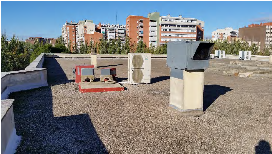
CUBIERTA UBICACIÓN PANELES SOLARES
