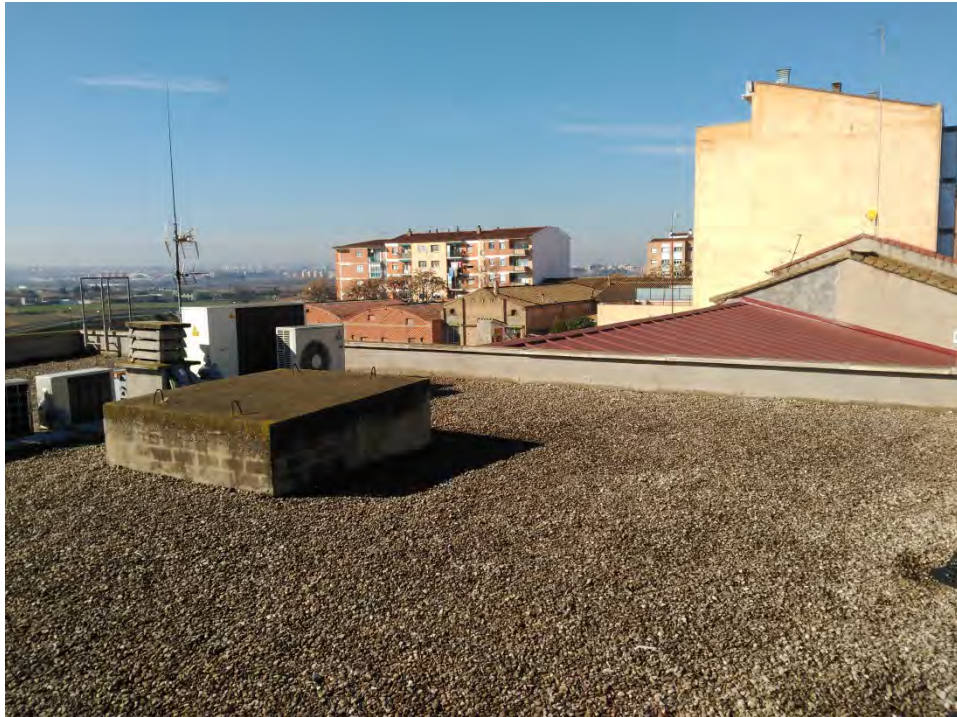
CUBIERTA JUNTA DE DISTRITO - UBICACIÓN ARMARIO TÉRMICO
