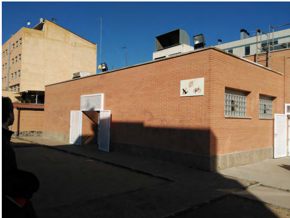
FACHADA TRASERA CENTRO DE MAYORES
