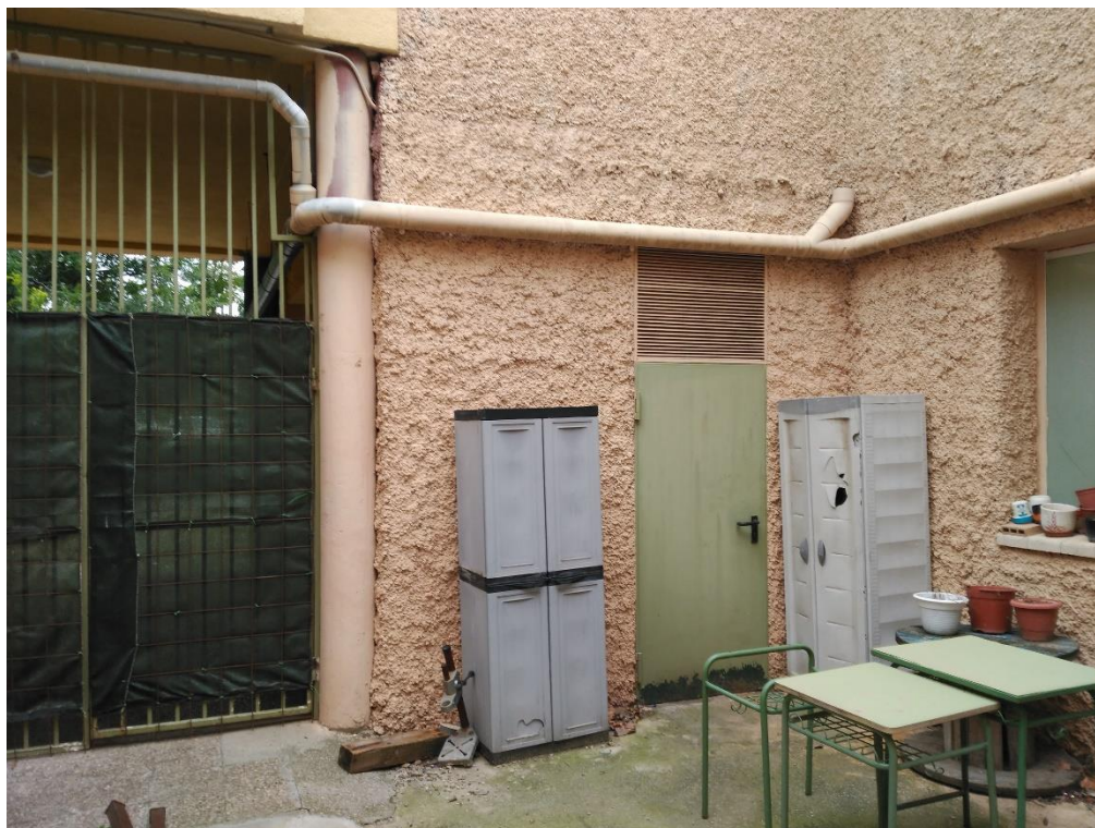
ACCESO SALA DE CALDERAS 1
