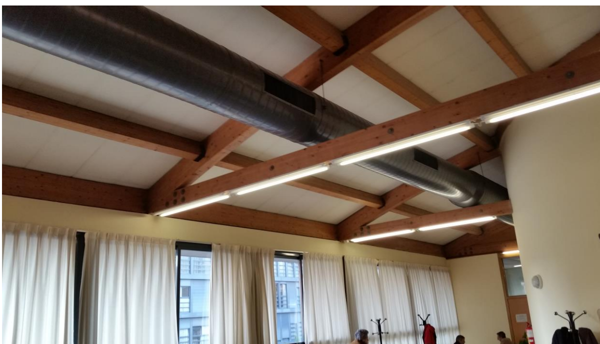
CONDUCTO DE IMPULSIÓN EXISTENTE
