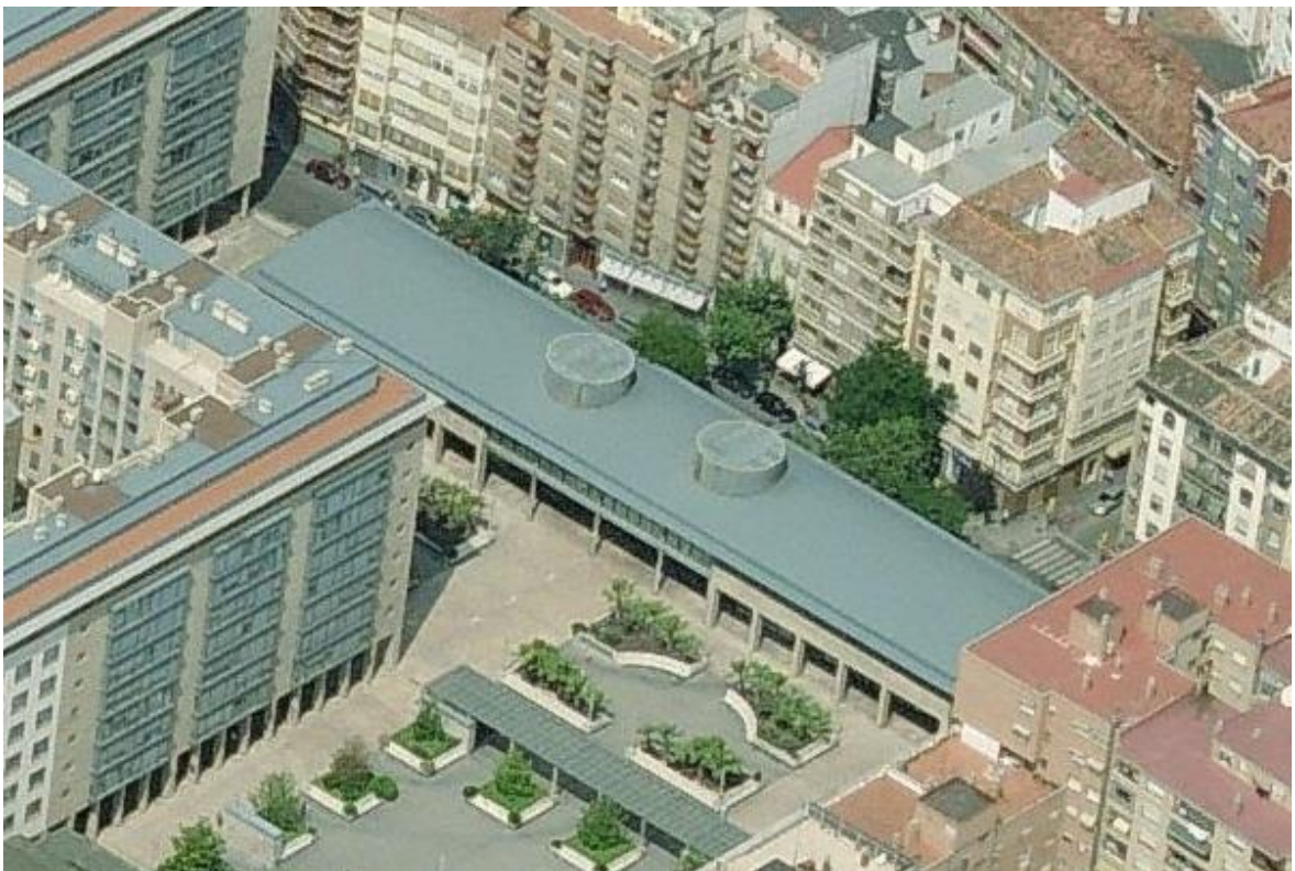
VISTA AÉREA CENTRO GOYA. SE OBSERVA ALTILLO CIRCULAR DONDE SE UBICAN EQUIPOS ACTUALES Y DONDE SE UBICARÁN NUEVOS EQUIPOS (ALTILLO IZQUIERDO)
