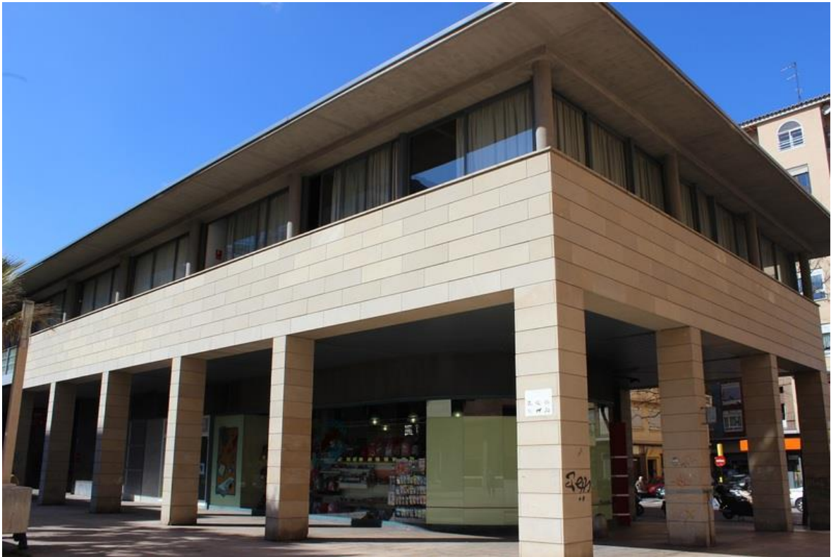
VISTA FACHADA CENTRO GOYA DESDE PLAZA DE MARIANO ARREGUI CANELA
