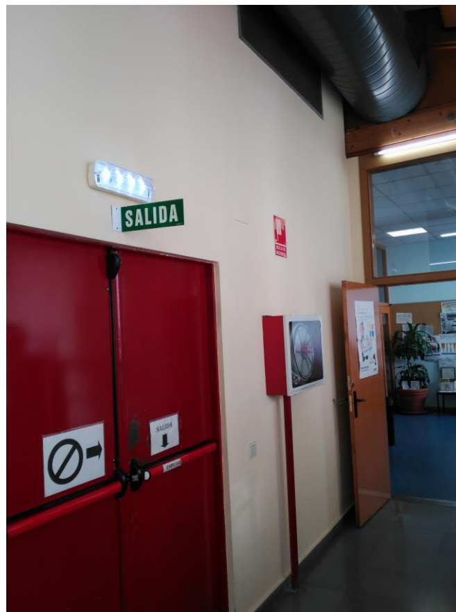
PARED DONDE SE UBICARÁN LAS REJAS DE RETORNO. EN LA PARTE SUPERIOR SE OBSERVA LA REJA EXISTENTE QUE SE EMPLEARÁ PARA LA EXTRACCIÓN
