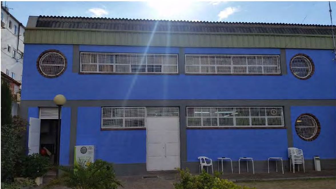
FACHADA VISTA DESDE PATIO EXTERIOR. PUERTA DE LA SALA DE CALDERAS ACTUAL ABIERTA
