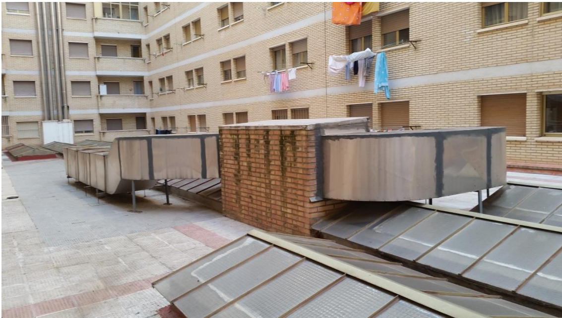
CONDUCTOS DE CHAPA A RETIRAR EN PATIO INTERIOR Y CASETA UNIDAD EXTERIOR
