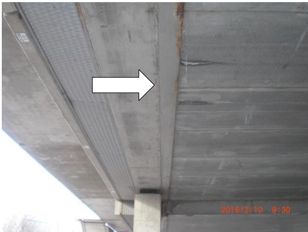
FOTO 5 CHAPA SOPORTE ACUEDUCTO
