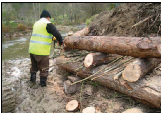
Fotos 10 y 11. Detalle de entramado vivo de pared simple y de la realización de los cortes en bisel de acabado.
