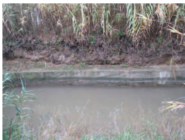
Fotografía 9. Margen izquierda de la acequia, repoblada de caña y con un murete de hormigón a pie de talud del cauce (PK 0+150m).
