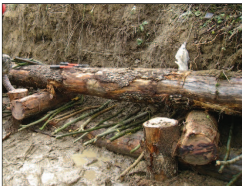
Fotos 8 y 9. Detalles: primer piso del entramado simple con troncos verticales, horizontales y transversales (Izquierda) y entramado con las estacas y fajinas insertadas (derecha).
