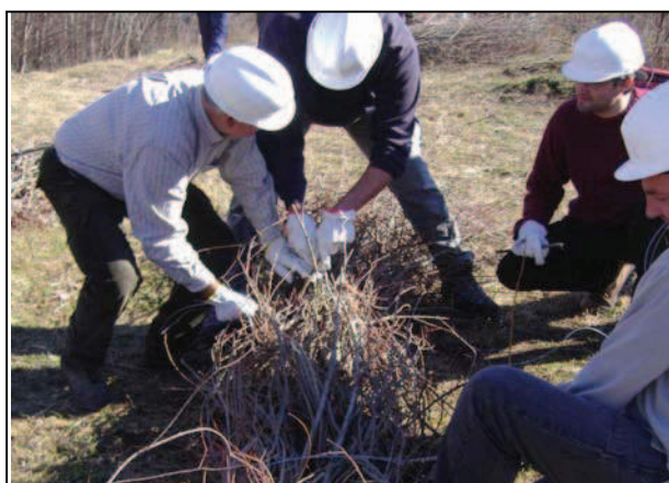
Foto 7. Detalle de la ejecución de la fajina de ramaje
