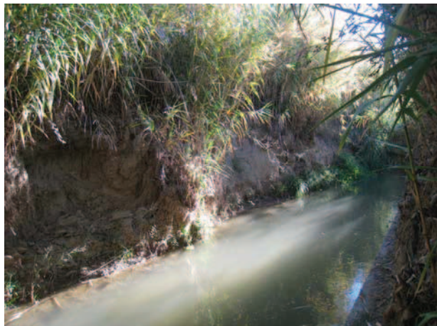
Fotografía 10. Deslizamientos e incisiones consecuencia de la erosión producida por el agua en la parte baja del talud y el propio peso de los rizomas. Tramo C.
