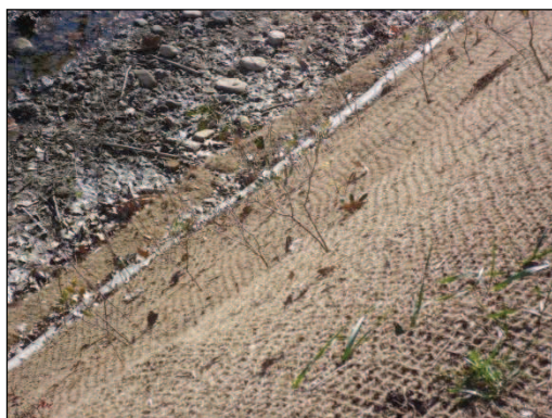
Foto1. Detalle de red de coco instalada.
