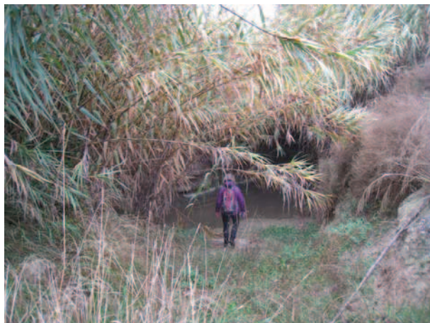
Fotografía 11. Acceso existente a la acequia, por la margen derecha (PK 0+175m).
