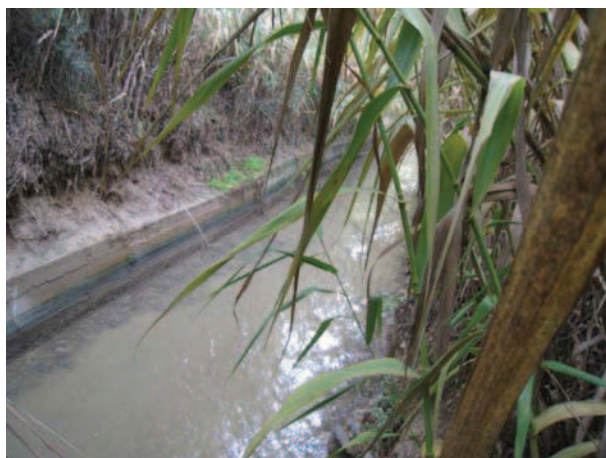
Fotografía 4. Vista del interior de la acequia desde la margen derecha (PK 0+100), donde se va a realizar la actuación. Presencia de masa monoespecífica de caña ( Arundo donax L.).
