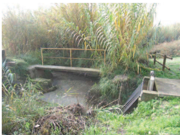
Fotografía 22. A la derecha, desagüe de la acequia hacia el espacio de interés natural del Galacho de Juslibol.
