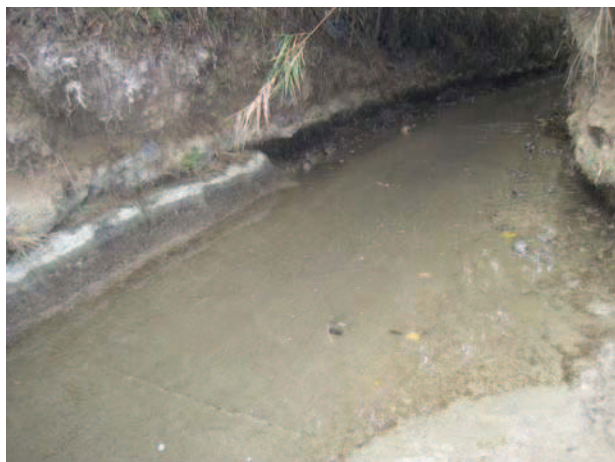
Fotografía 17. Lecho de la acequia, de 3m de anchura, hormigonado en su base.
