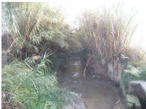
Fotografía 21. Imagen del interior de la acequia en el punto final de actuación (PK 0+350)
