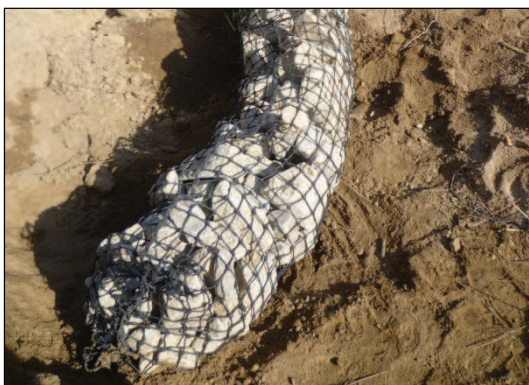
Foto 3.Detalle de un gavión flexible.
