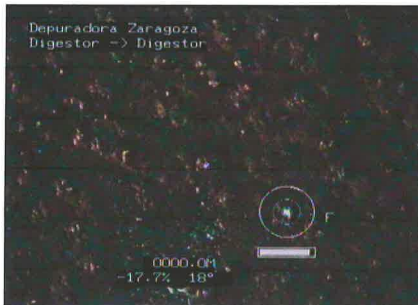
Fotografía: 1b 0,1m, Inicio de la inspeccion, vista desde boca superior digestor
