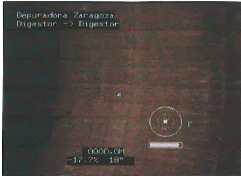
Fotografía: 3b 0,1m, Vista lateral paredes desde parte superior
