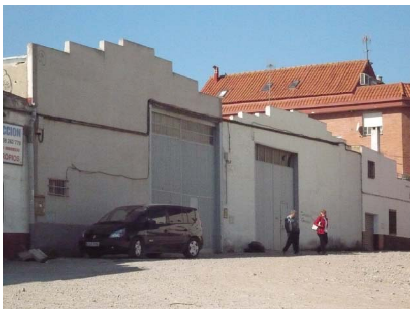
Fotografía realizada desde la calle Piscis. Se aprecian las fachadas principales de las naves a demoler.
