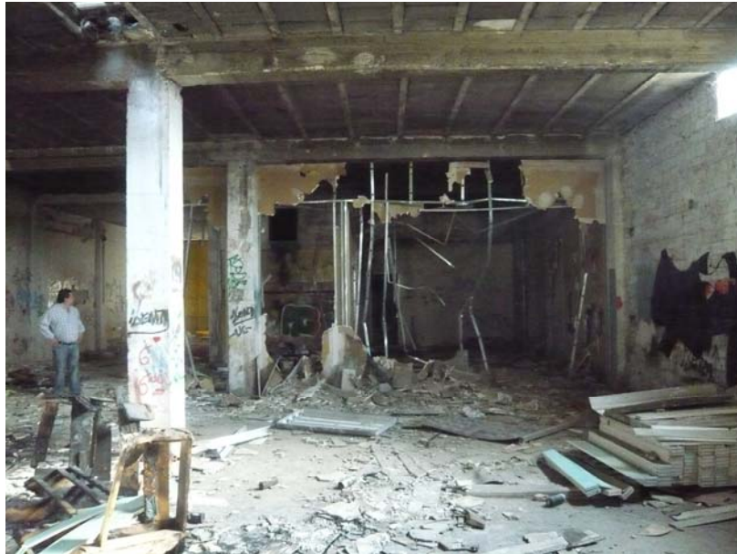
Fotografía realizada del interior de las naves a demoler.
