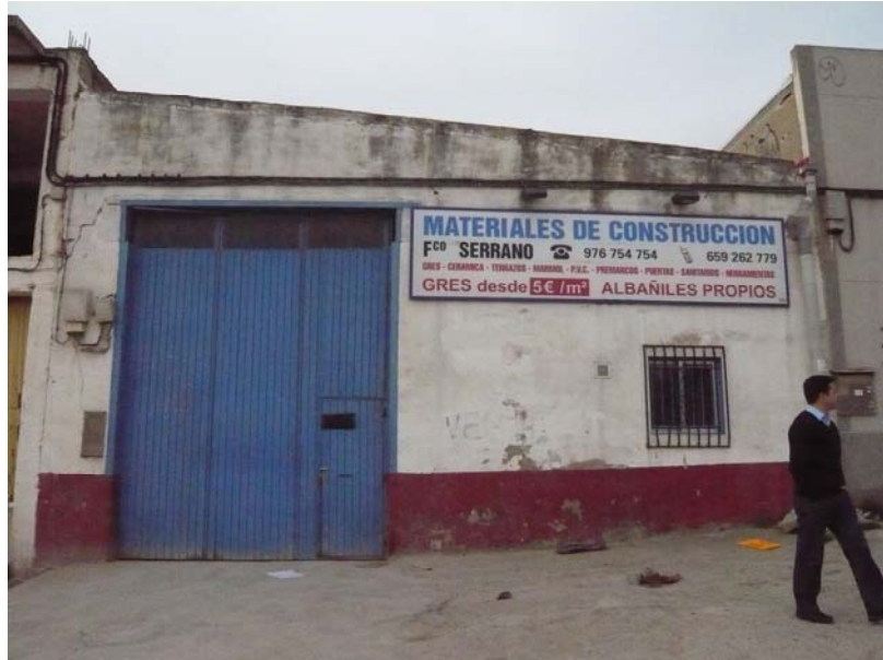
Fotografía realizada desde la calle Piscis. Se aprecia la fachada principal de una de las naves a demoler.
