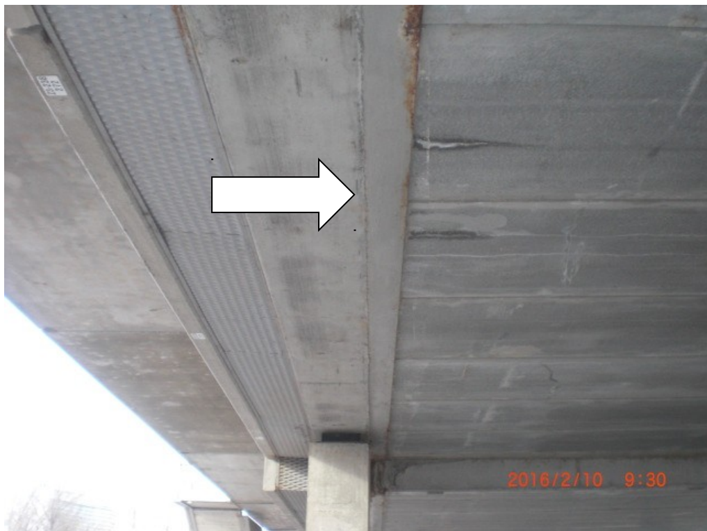
FOTO 5 CHAPA SOPORTE ACUEDUCTO
