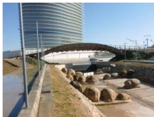
10.-PUENTE CANAL AGUAS BRAVAS
