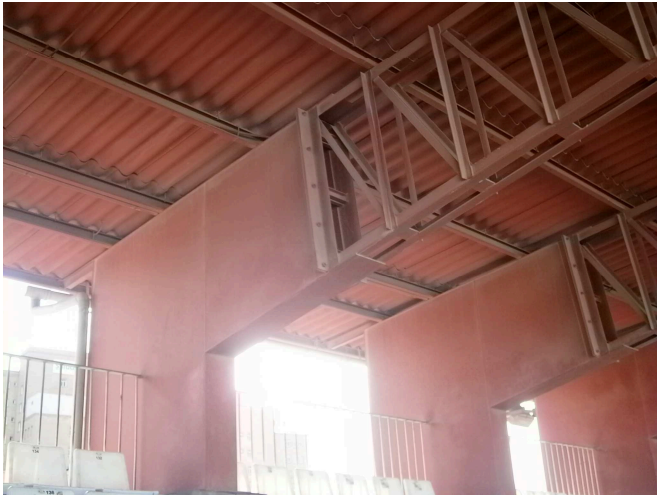
Bajo cubierta este
