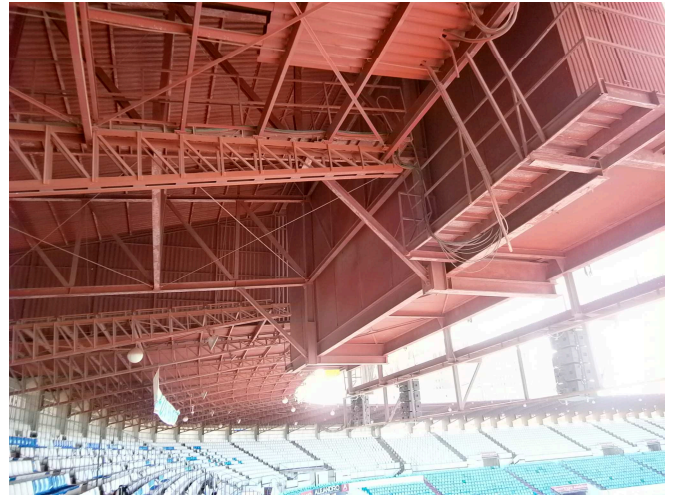
Bajo cubierta fondos
