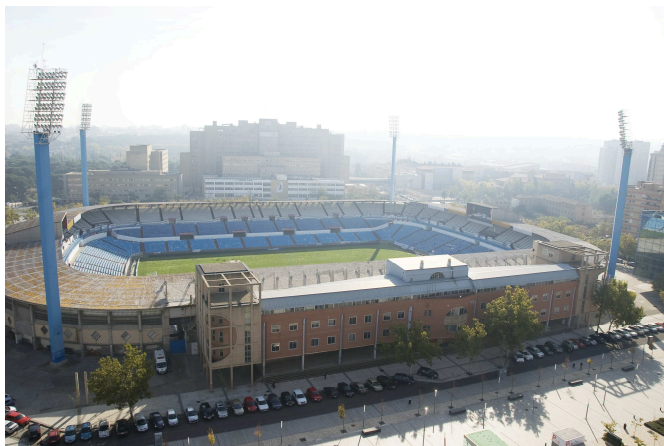
Exterior fachada oeste
