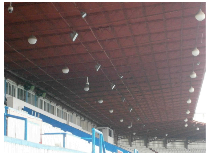
Bajo cubierta oeste
