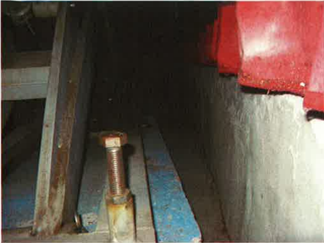
Foso apoyo plataforma hidráulica
