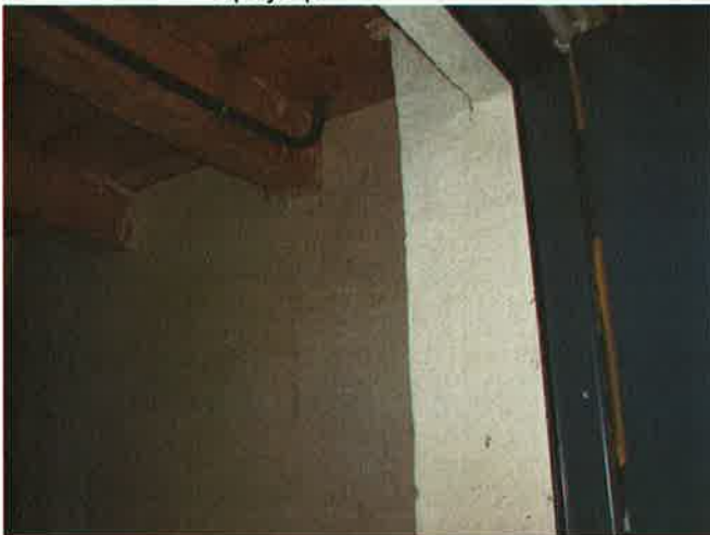
Forjado madera lateral foso hacia escenario
