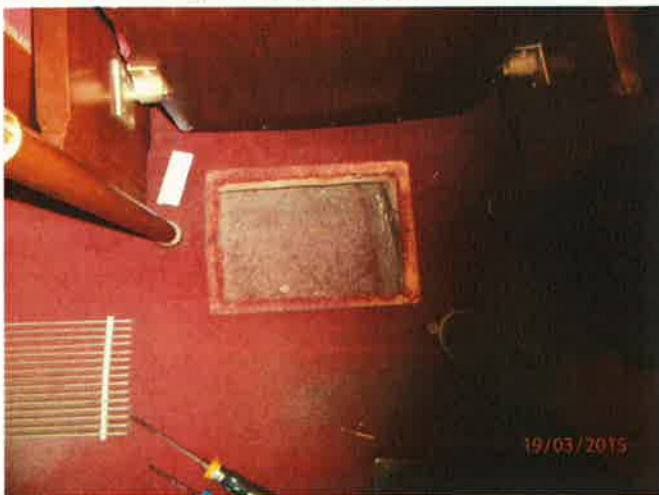
Hueco rejilla ventilación
