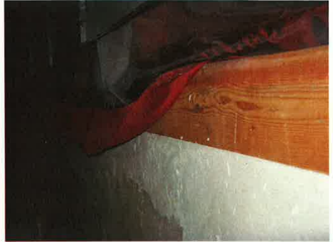
Muro lateral foso hacia butacas
