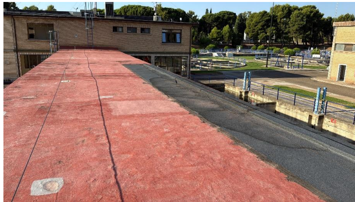
Figura 1: Estado actual de la superficie de la cubierta. Zona 1.
