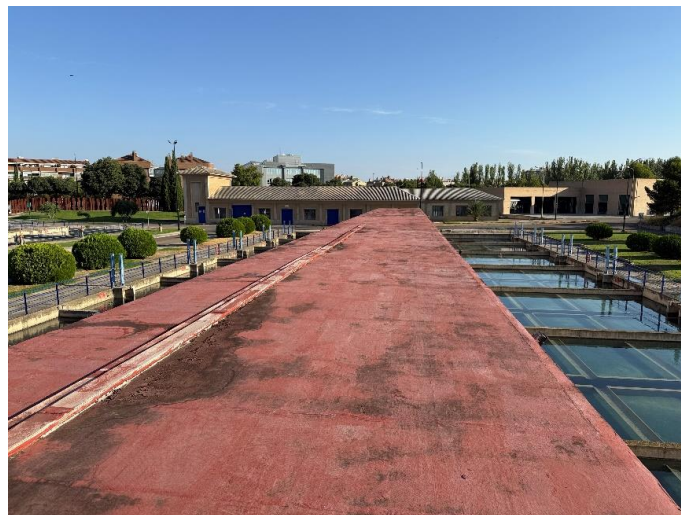
Figura 2: Estado actual de la superficie de la cubierta. Zona 2.
