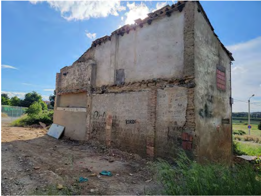
Fachada sur y este. Zona del antiguo Bloque C ya demolido.
