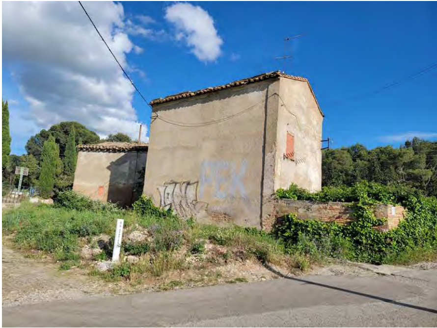
Fachada norte y oeste
