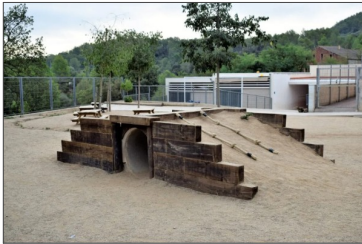
Zona futura de desnivel
