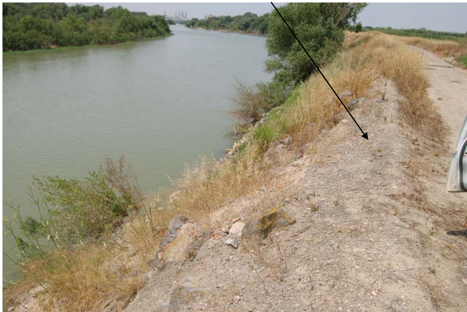
Distintas alturas y anchuras de los cordones sobre rasante del camino
