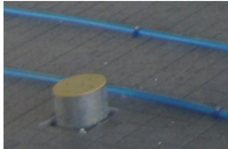
Detalle de registro de STC una vez colocado el suelo radiante
