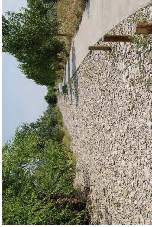
Senda en hormigón (reparada con cargo al Ayuntamiento) y camino de ribera con desaparición de firme.
