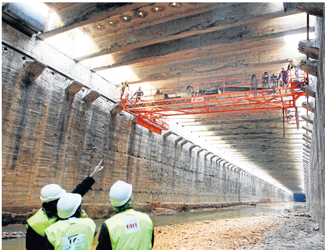
Los operarios trabajan en la renovación del cubrimiento del río Huerva.
