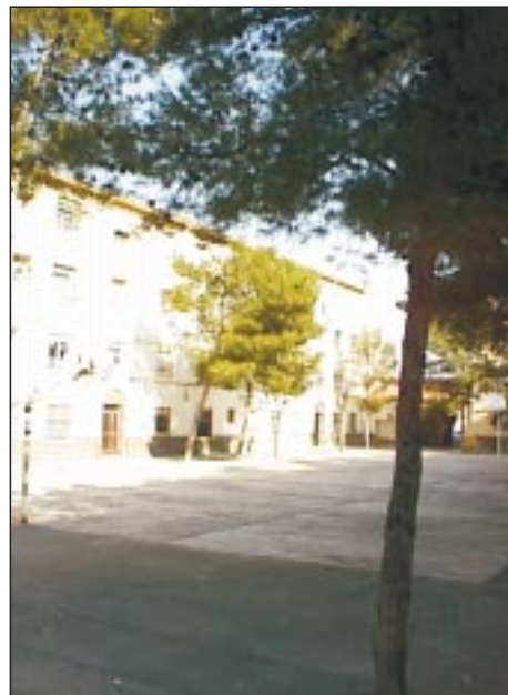
GRUPO DE VIVIENDAS SAN JORGE
