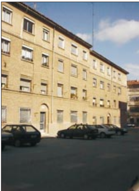
GRUPO DE VIVIENDAS SAN JORGE
