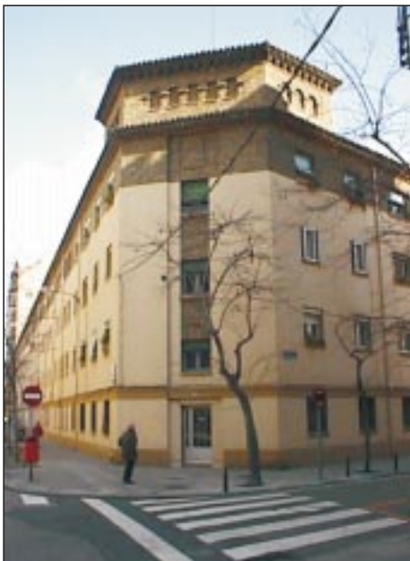
GRUPO DE VIVIENDAS R.E.N.F.E.
