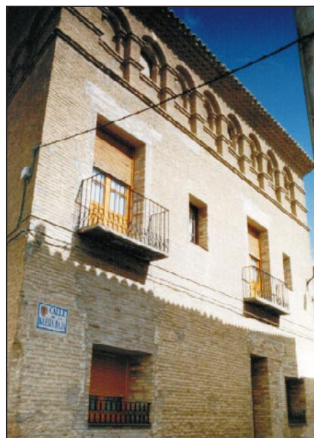
C/ IGLESIA BAJA Nº 2, VILLAMAYOR
