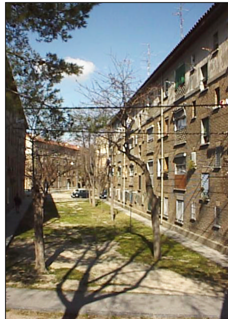
GRUPO DE VIVIENDAS ARZOBISPO DOMENECH
