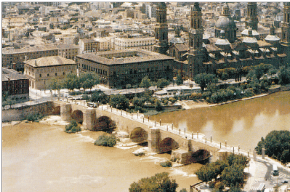
PUENTE DE PIEDRA
