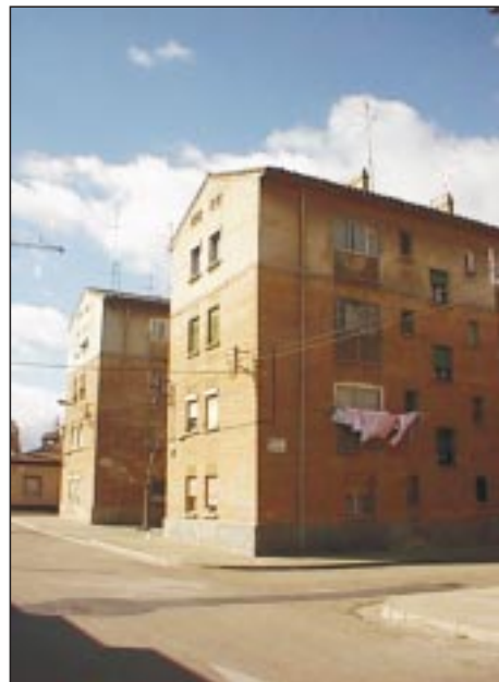
GRUPO DE VIVIENDAS EN CASETAS
