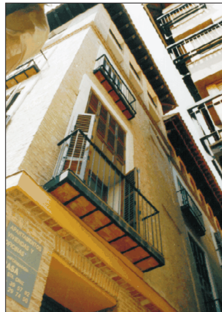
PALACIO DEL PRIOR ORTAL
