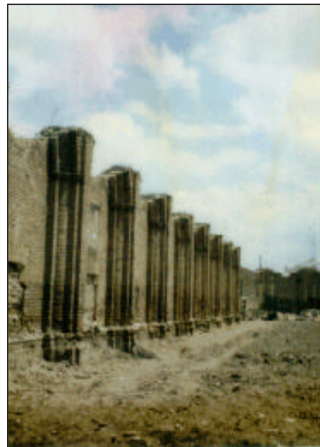
RESTOS DEL CLAUSTRO
