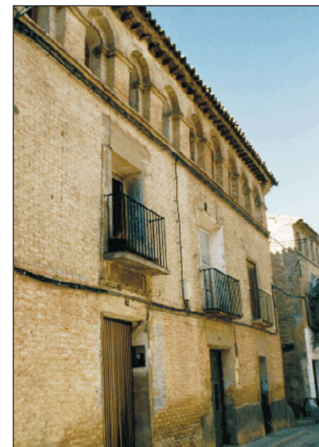
C/ CARNICERIA nº 1. VILLAMAYOR
