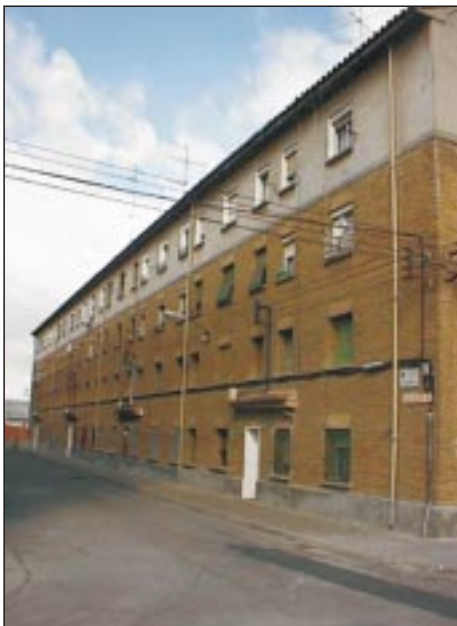
GRUPO DE VIVIENDAS EN CASETAS
