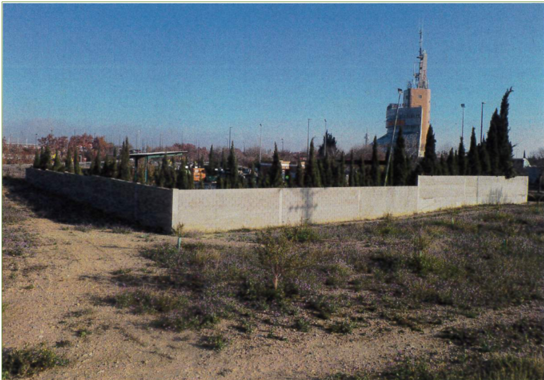
Punto limpio Universidad-Delicias, hacia el suelo calificado como zona verde ZV(PU)89.05.
