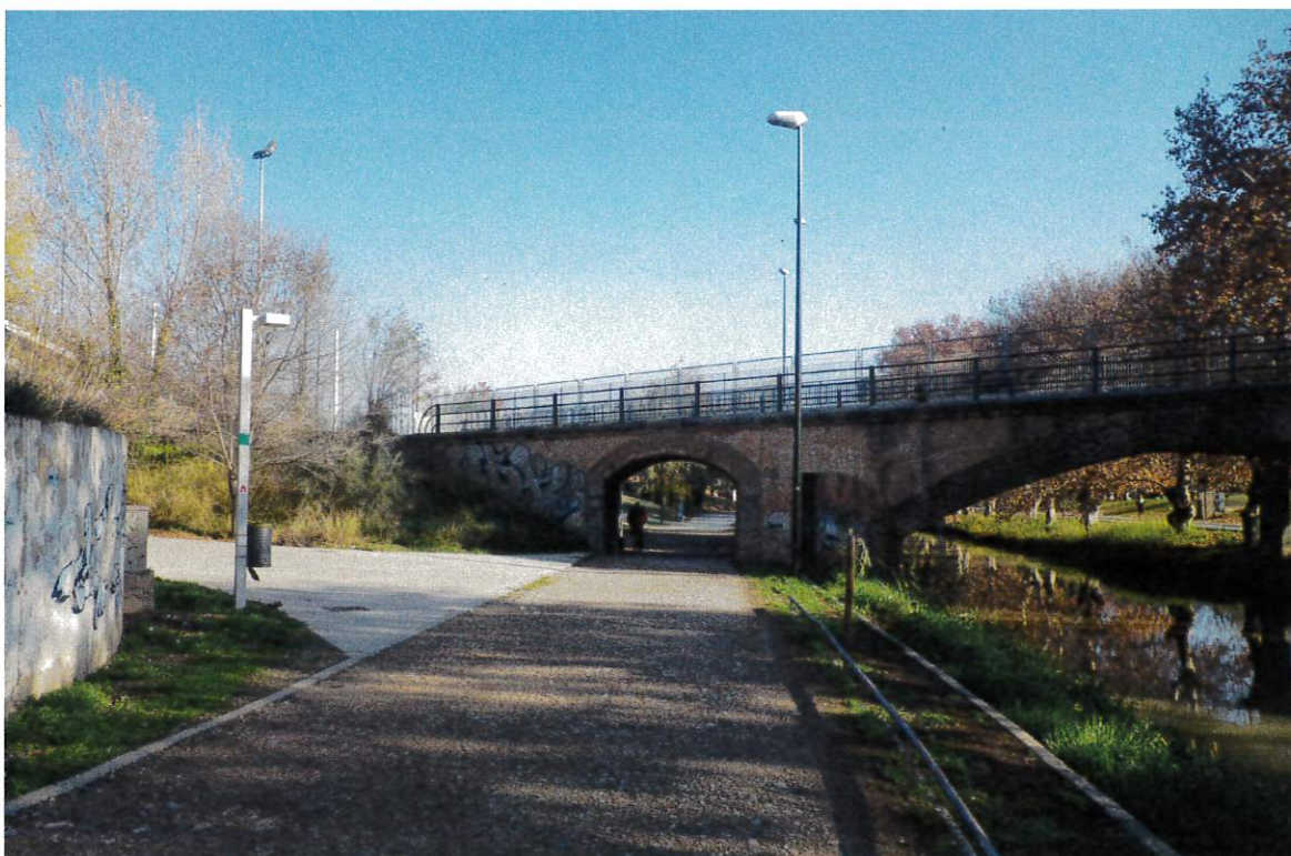
10. Vista de la zona incorporada a la ZV 57.88, hacia el este.
