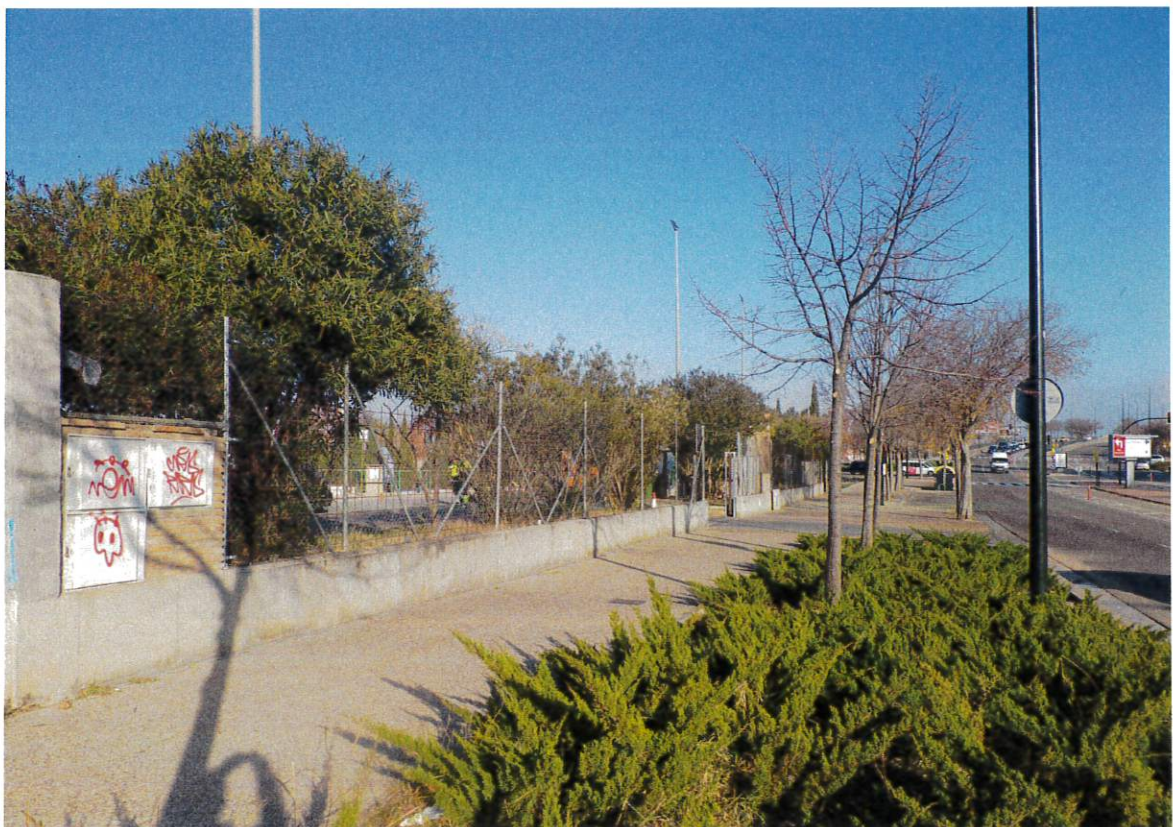
2. Frente del punto limpio hacia avenida Gómez Laguna.
