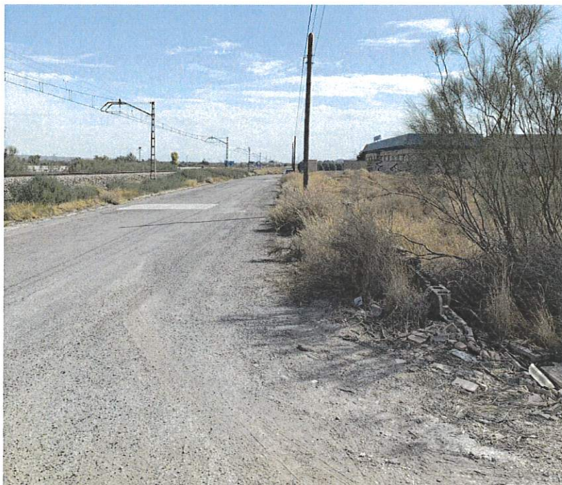
FOTOGRAFÍA 12. (Linde N de la F-86-5 a la vía de Servicio hacia el H-86-14)
