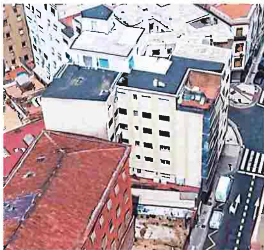
Imagen: medianera Cortes de Aragón 8
