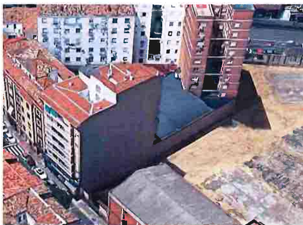
Imagen: medianera Cortes de Aragón 24
