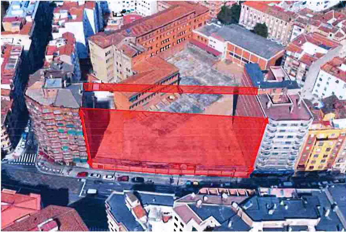
Imagen: frente a la avenida Goya
